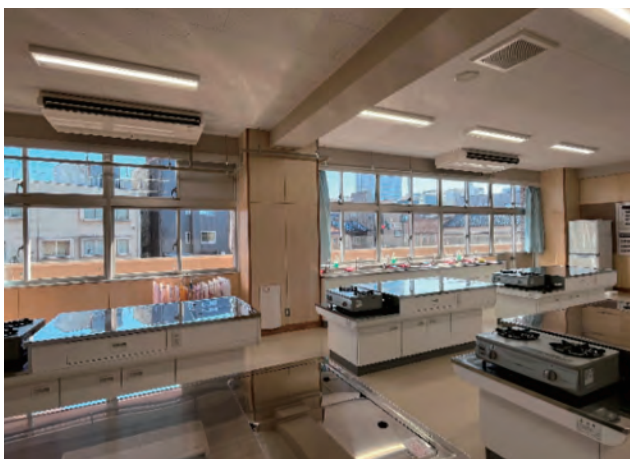
特別教室等への空調設備の整備
